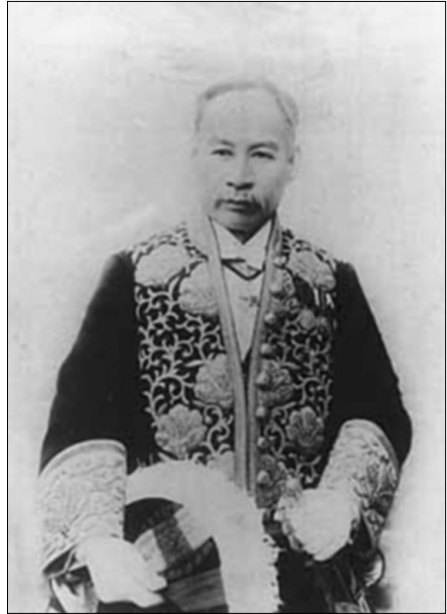
▲ 한말 고관 출신으로서 남은 생애를 조국 광복의 길에 바친 동농 김가진 선생
